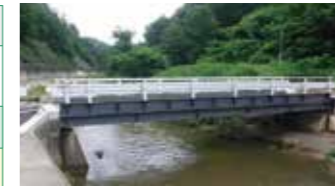
2020年6月施工(福島県)
