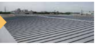
施工後10年以上経過異状なし
