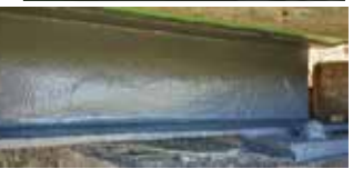
桁端3種ケレンA後塗布
