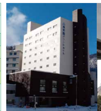
1982年施工現在も健全 30年ぶりの塗り替え
